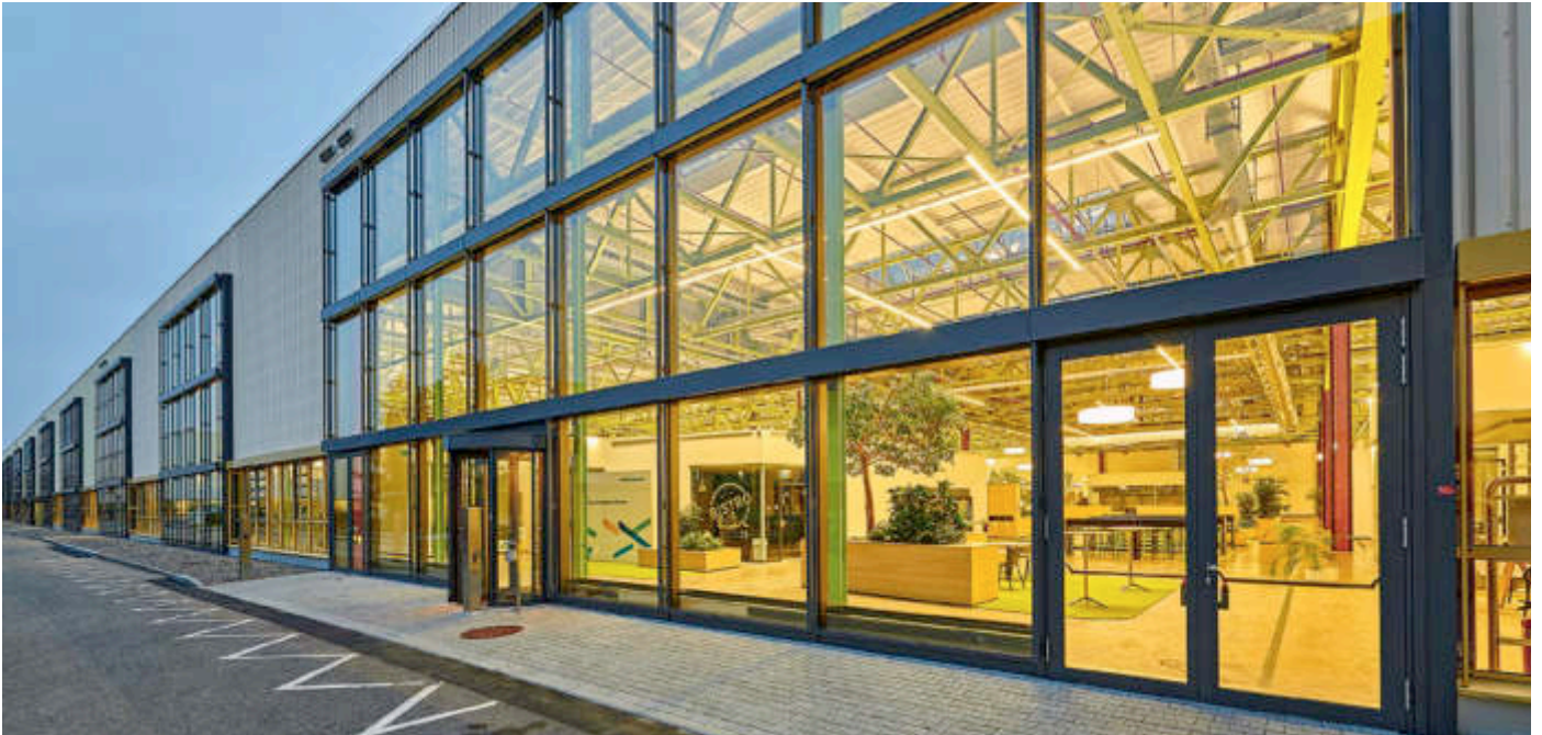
Die Außenfassade erhielt eine zusätzliche Innendämmung aus Isopaneelen. Großflächige Pfosten-Riegel-Fassaden verbessern den Tageslichteintrag.
